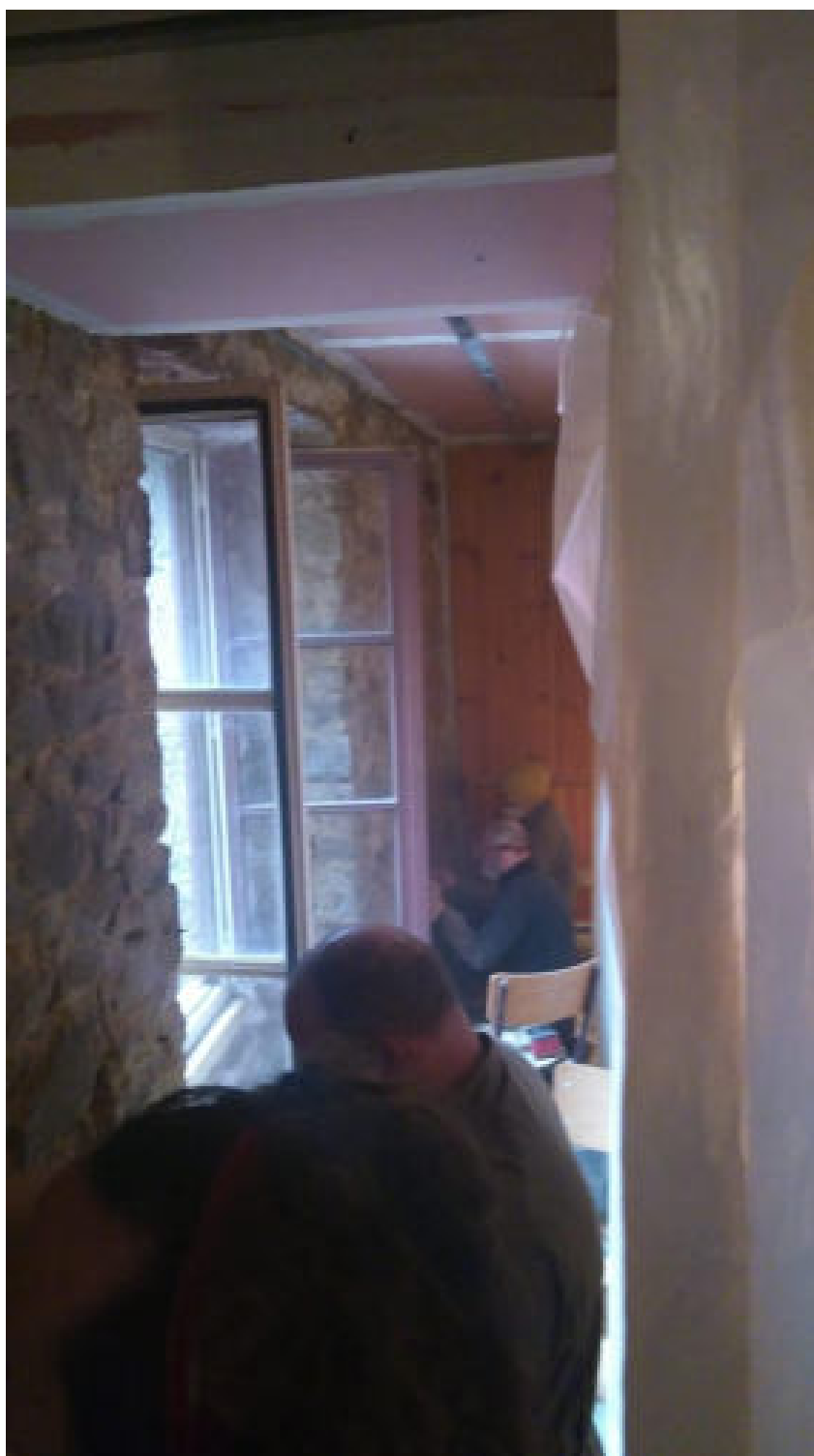
29/01 : Chantier participatif avec nettoyage des murs en pierre du café
